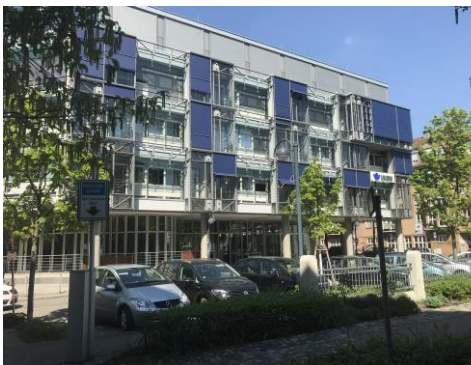
UKBW – Standort Karlsruhe
